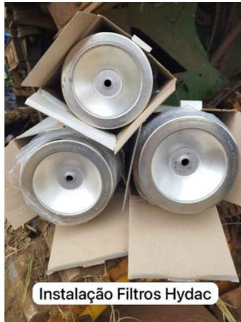
Figura 6: Elementos Hydac instalados na máquina;
